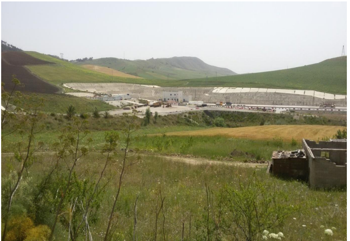
Photo 04 : Chantier de construction de l'autoroute (commune de Zighoud Youcef)
